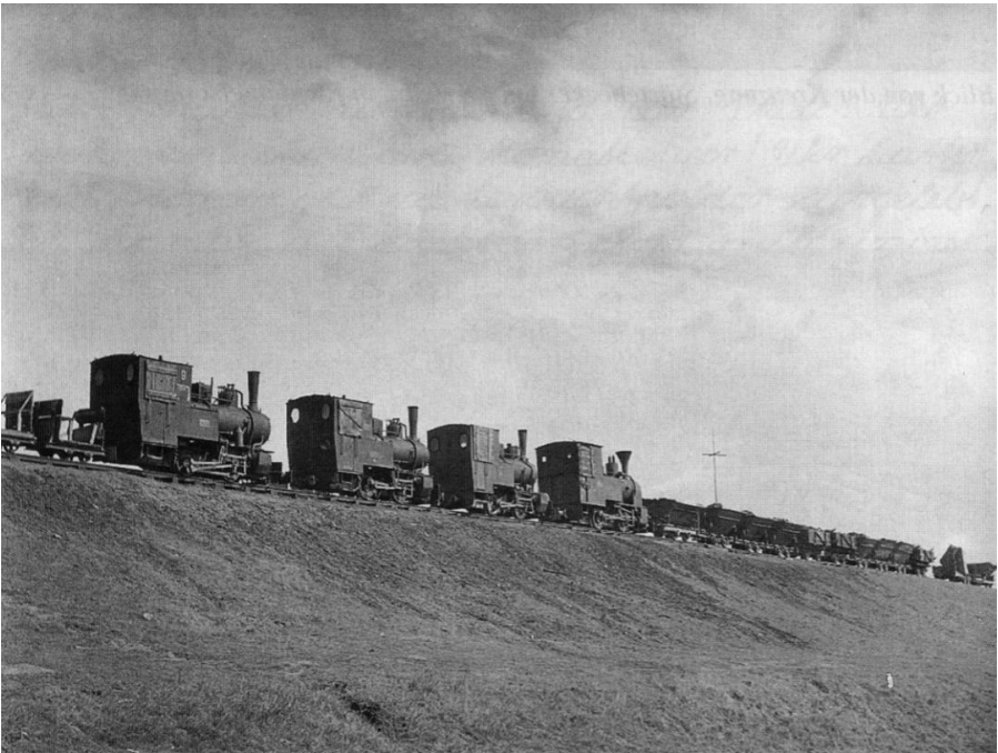
Kleibodentransport mit Lore und Teckel
