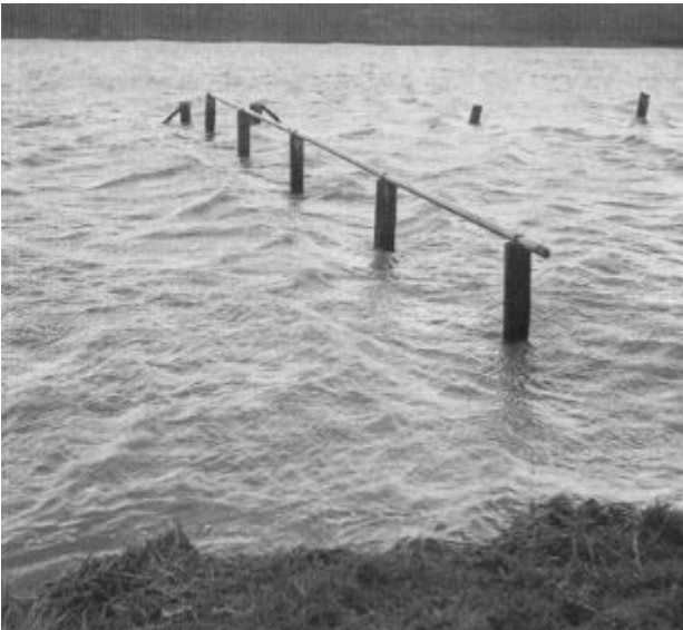
Überschwemmungen 1960: Gehsteg über den Sammelkanal am Störtebekerdeich
