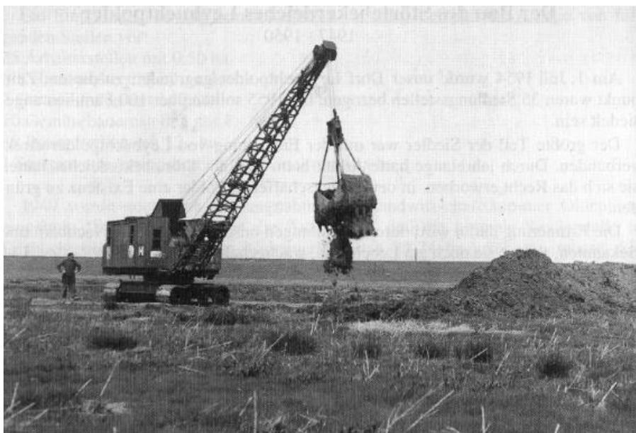
Baubeginn am Störtebekerdeich
