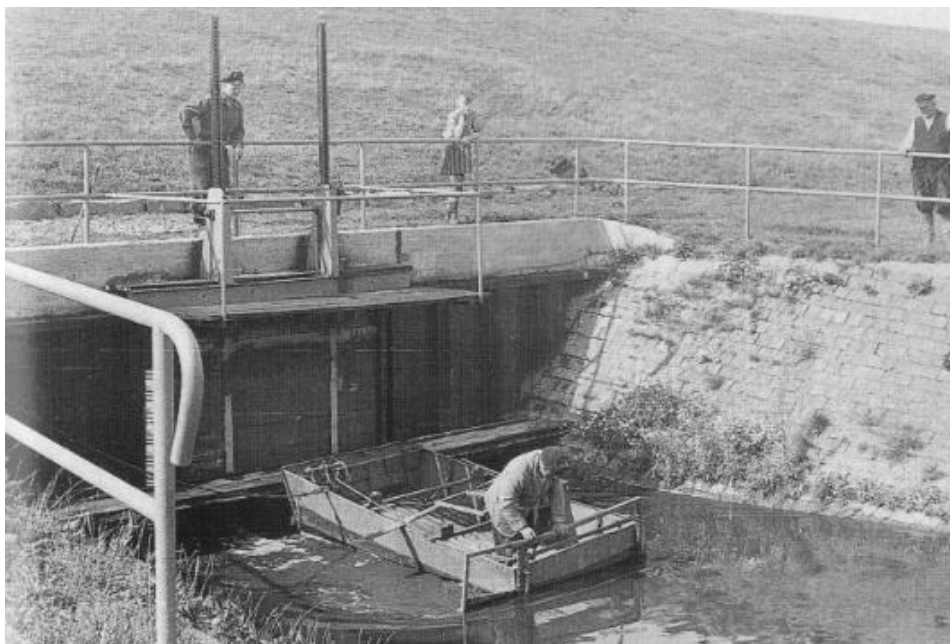
Außenseite des Siels mit Mudderpflug
